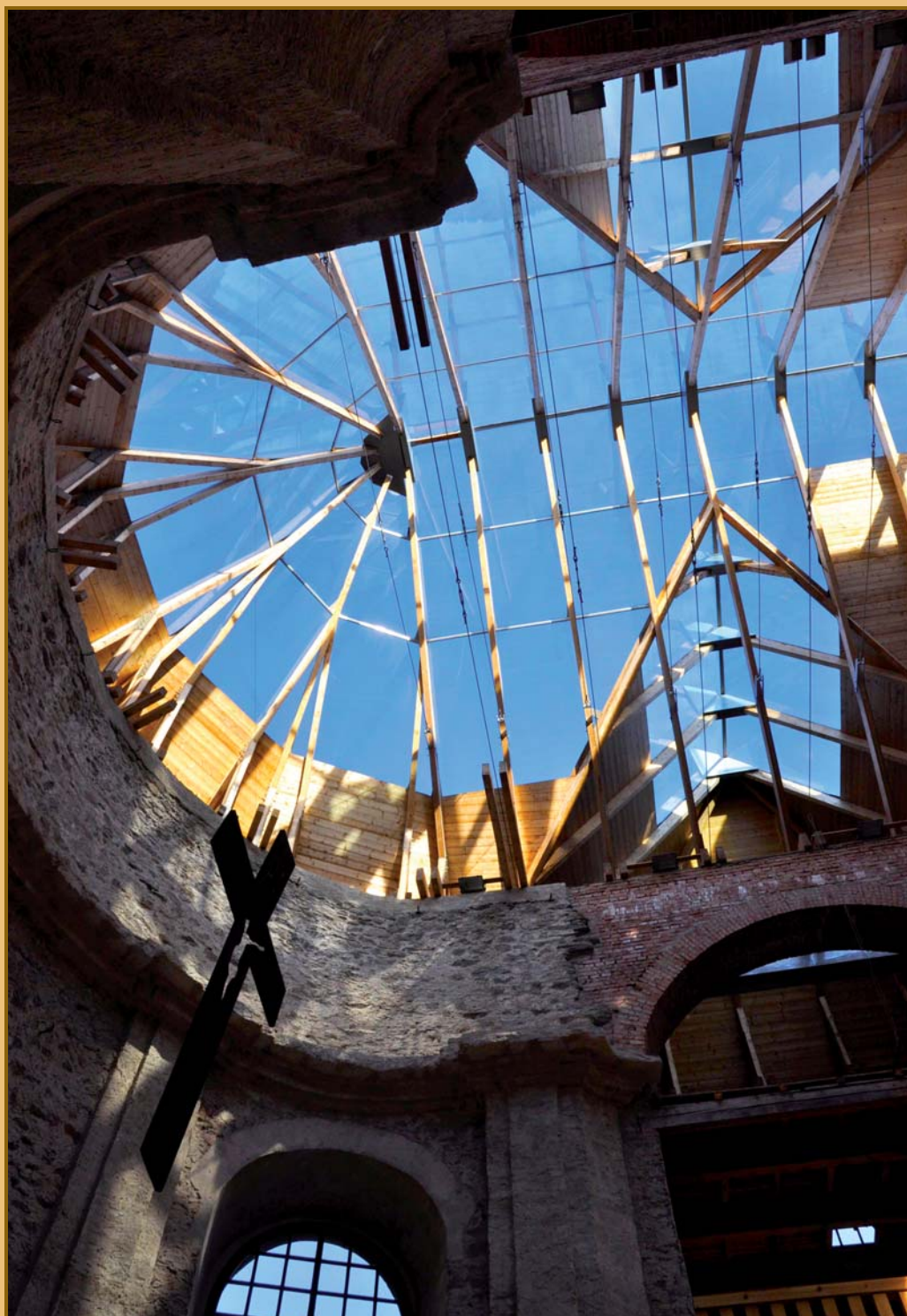
Interiér kostela - zastřešení ▲ Kostel Nanebevzetí P. M. Neratov - celkový pohled (Foto: Karel Rechlík) ►
